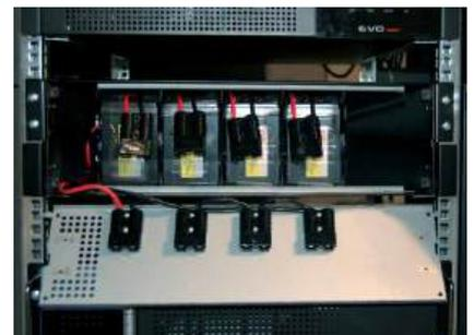
Questo permette ad un singolo operatore di poter installare facilmente il Battery Box e successivamente i Battery Pack al suo interno.
